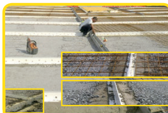
Eksempel på K-Form montert på 150 mm betonggulv
